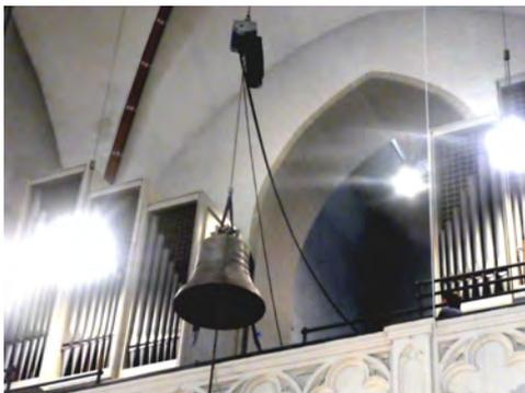
Jetzt wurde die Glocke hoch gezogen bis ca. 0,5 m über die Brüstung der Orgelempore und dann mit einem Schwenk bis zur Mitte des Kirchturmes gezogen, umgehängt an den zweiten Stahlseilzug und bis in die Glockenstube hochgezogen. Hier oben wurde die Glocke mit dem Glockenjoch verbunden und in die Kugellager montiert, sowie die Anschlussarbeiten, Glockenantrieb und Elektro-Steuerungen.
