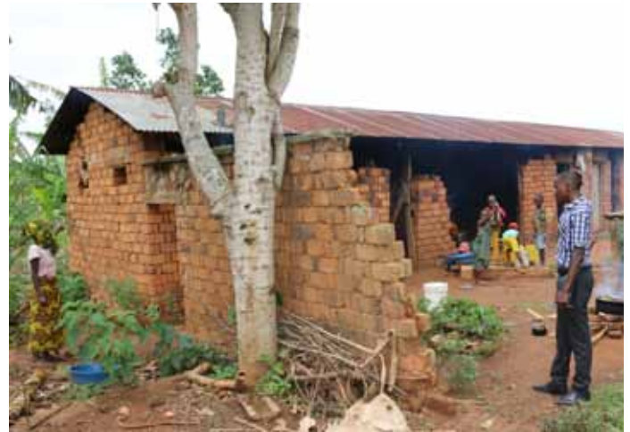
Haus in Bugorora nach dem Erdbeben am 10.09.2016
