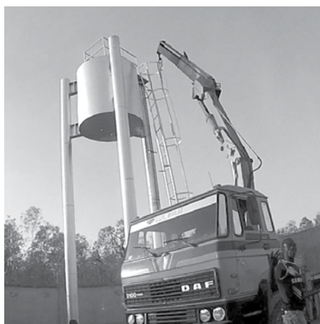
Der neue Wasserturm
