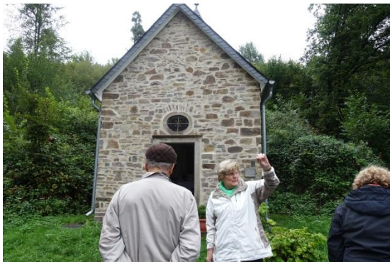
Frontansicht der renovierten Kapelle, uns zugewandt Frau Müller
