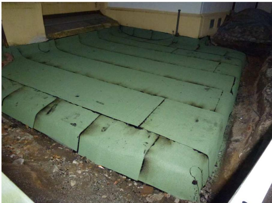
Bild: Aufbringen einer wurzelfesten Abdichtungslage
