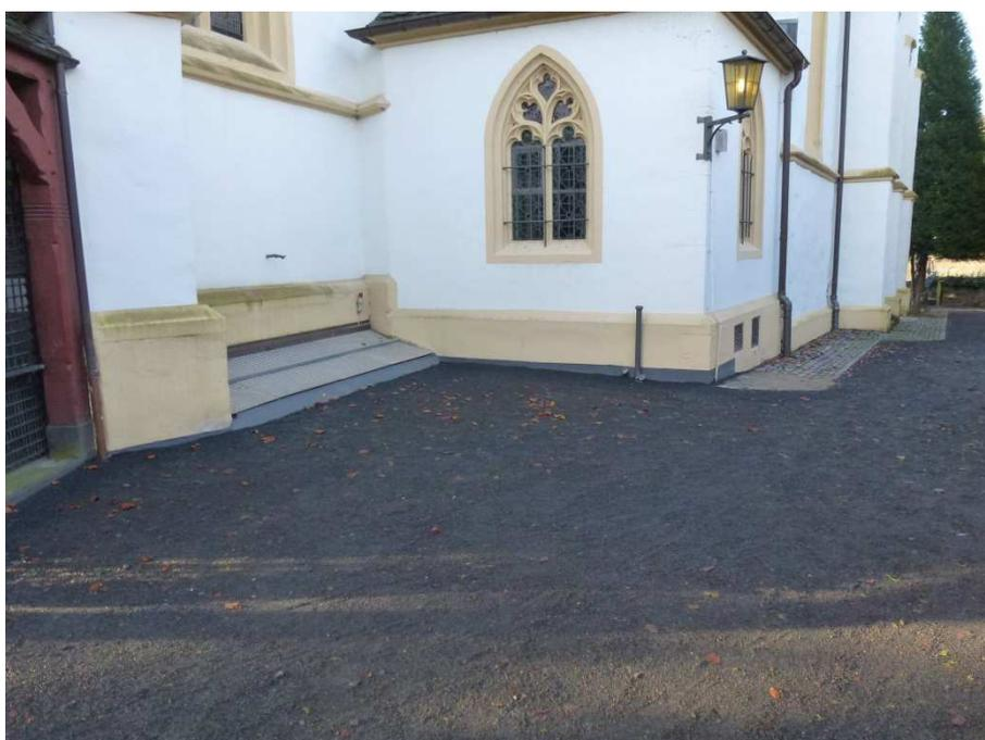
Bild: Wieder fertiggestellte Oberfläche mit wassergebundener Split Decke
