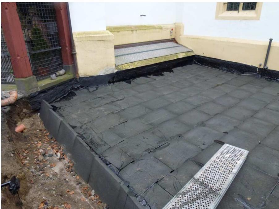
Bild: Aufbringen von 6 cm starken, Schaumglasplatten, eingeschlämmt in Heißbitumen als Dämmung (wasserdicht und schädlingssicher)
