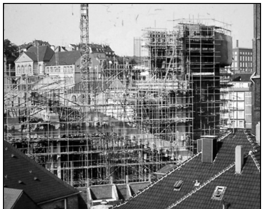
Bilder vom Kirchbau 1969 / 1970
