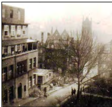
Zerstörungen an der Montania nach 1945 mit Ruine der Christuskirche am Oberdörnen.
