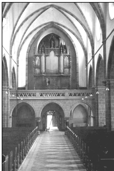
Nach der Renovierung 1940
