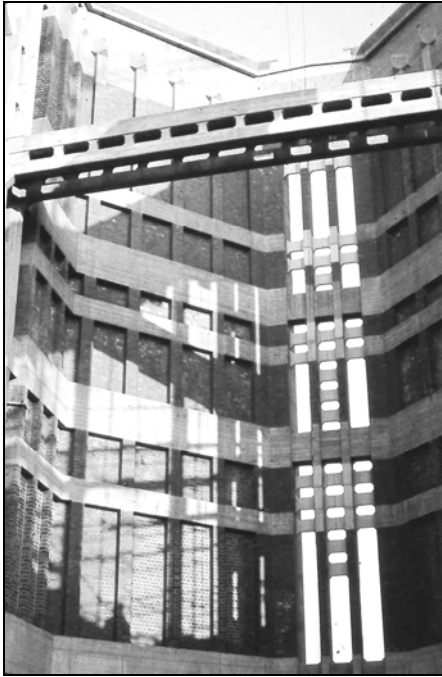
Rohbau des Chores
