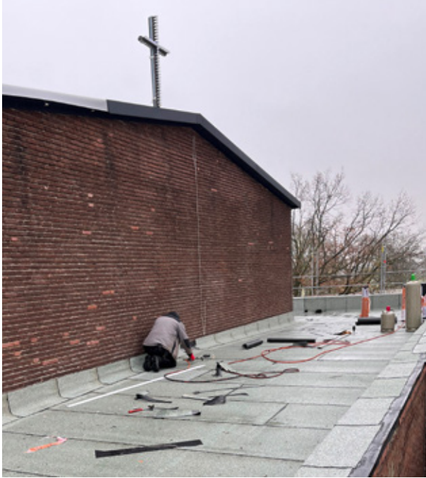
Dachdecker bei der Arbeit
