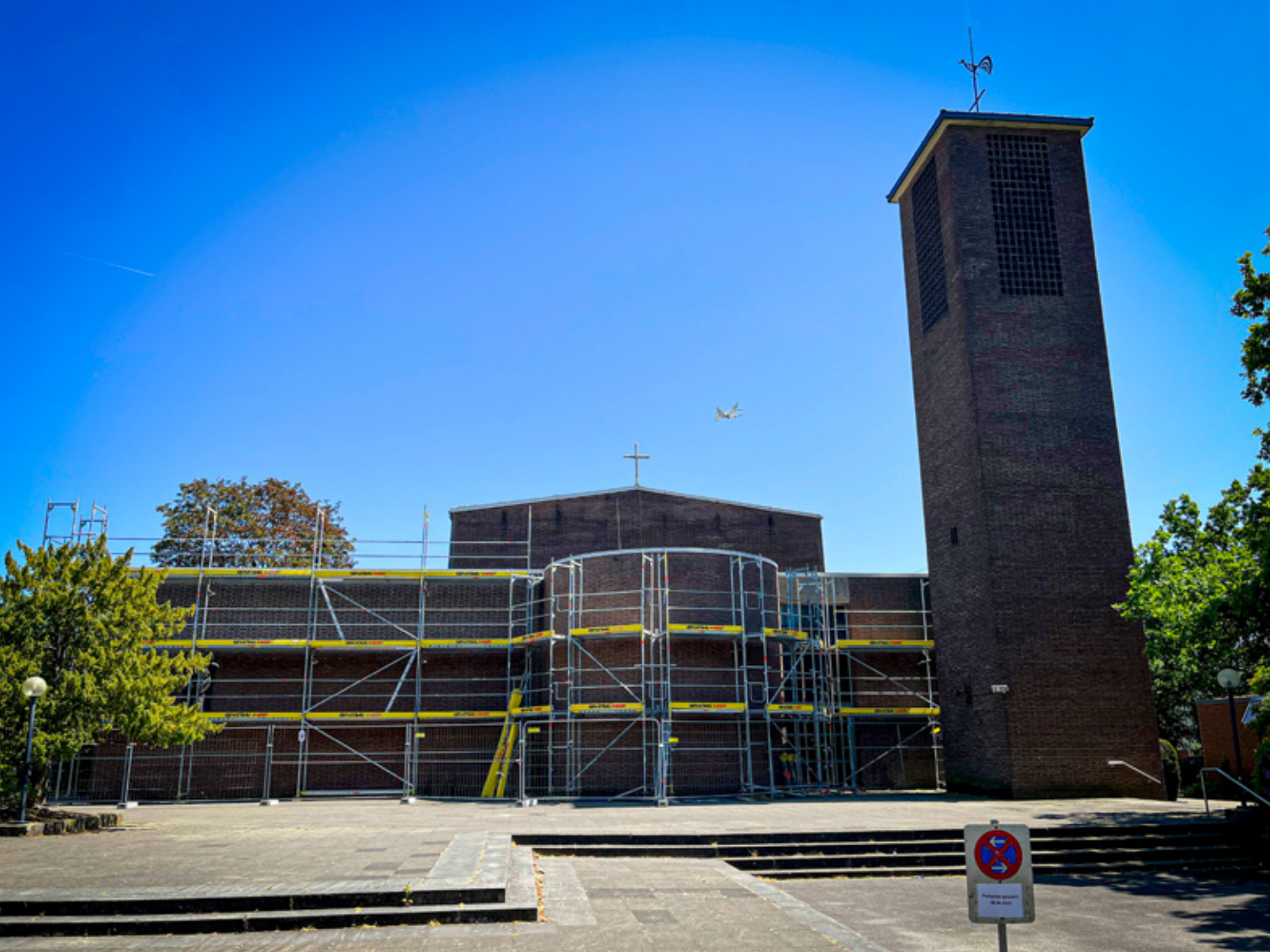
St. Antonius eingerüstet – gut gerüstet für die kommenden Jahre
