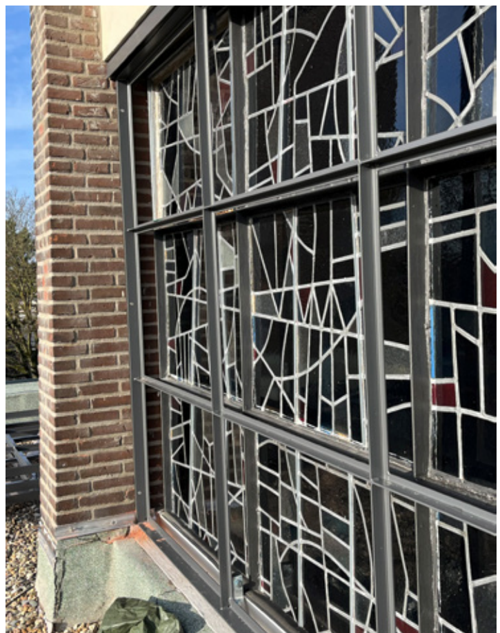
Schutzverglasung vor der Buntverglasung der Fenster
