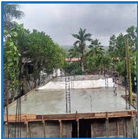
Gegossene Betonplatte beim Schulneubau in Haiti
