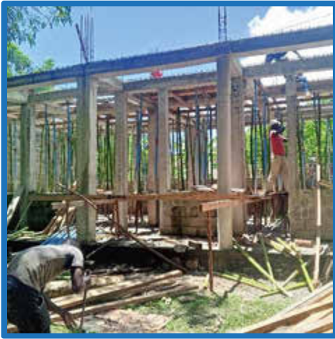
Baustelle in Chambellan
